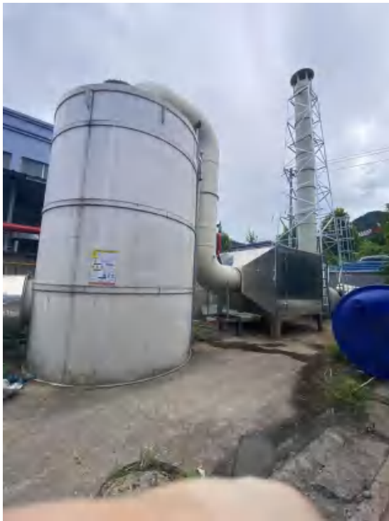
纤维素膜废气处理设施 (水喷淋+活性炭吸附)
